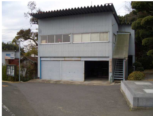
写真－10 オペレーター室
